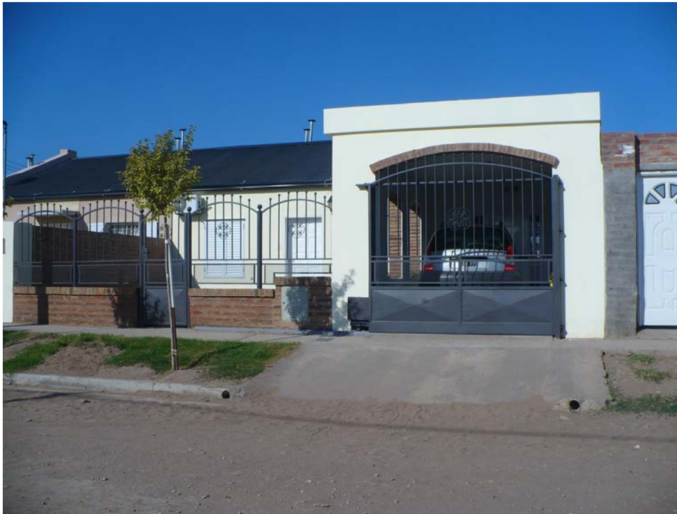
Imagen N° 4: imagen de vivienda reformada a menos de un año de ser entregada
