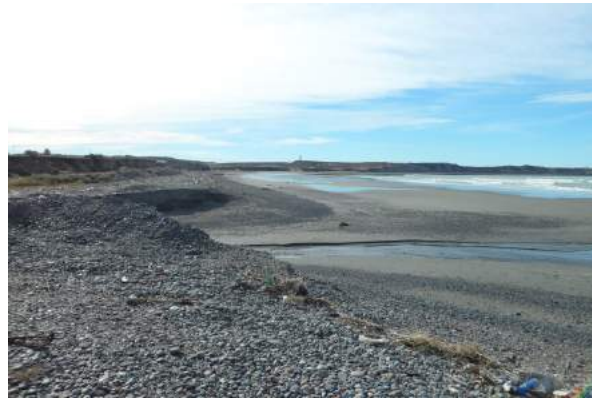
Foto N° 1: Vista Norte del cauce natural por el que se vierten aguas servidas
