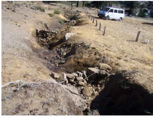
Sedimentación de diques. Comparación del mismo sector en Diciembre de 2008 y Abril de 2015.
