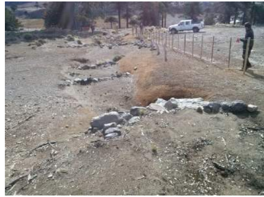
Sedimentación de diques. Comparación del mismo sector en Diciembre de 2008 y Abril de 2015.
