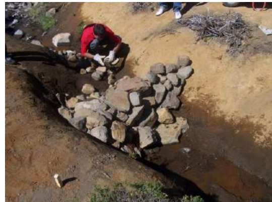
Construcción de diques.
