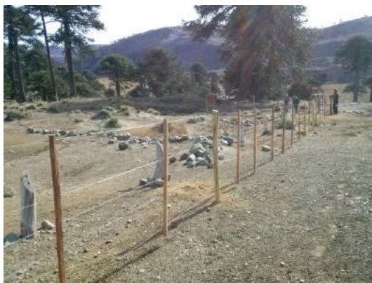
Construcción de alambrados.
