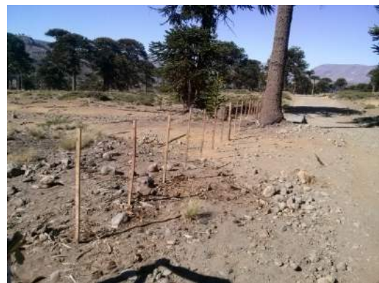
Construcción de alambrados.
